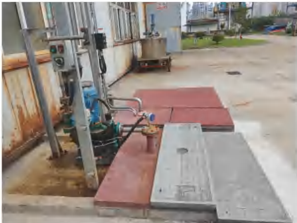
改造前废水集水井
