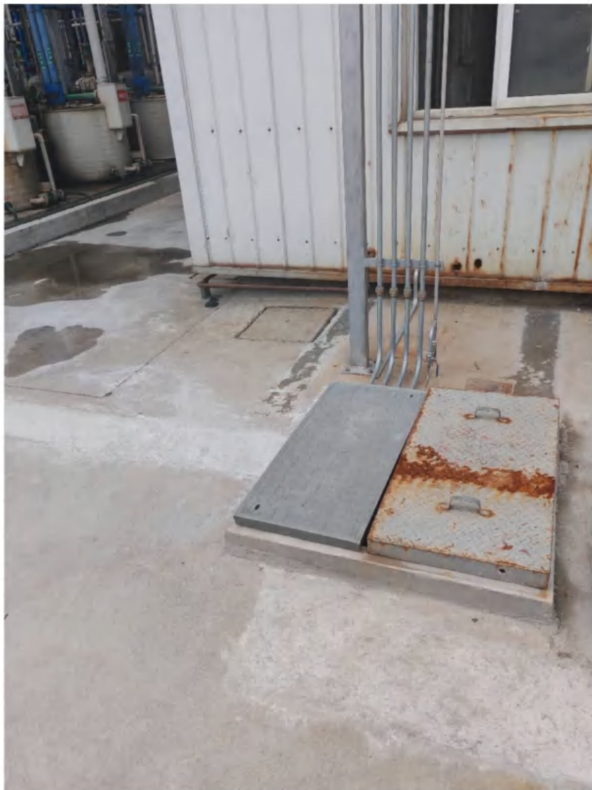
改造前废水集水井
